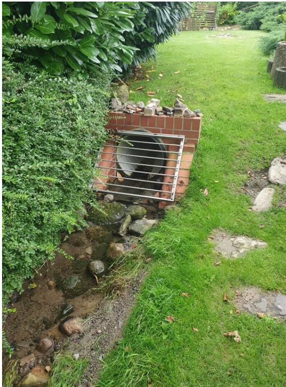
Abbildung 4: Auslauf der Entwässerungsrohrleitung in KV 23
